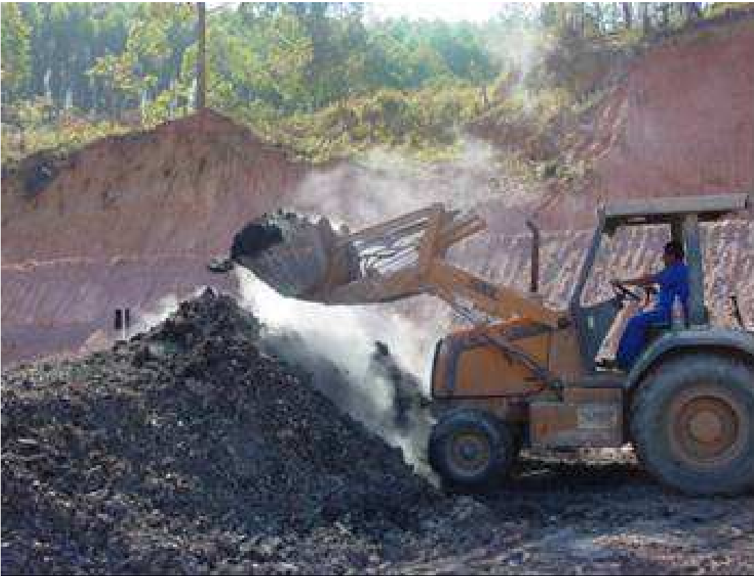
Figura 5 - Operação de revolvimento das leiras com a pá escavadeira
