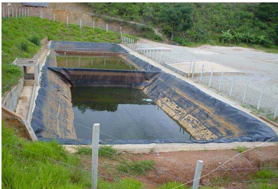
Figura 18: Exemplo de tanque impermeabilizado com manta de PEAD armazenagem de líquidos percolados (CHORUME) em aterro sanitário convencional. Fonte: Fernando Wolmer, 2007, CETESB, arquivo pessoal
