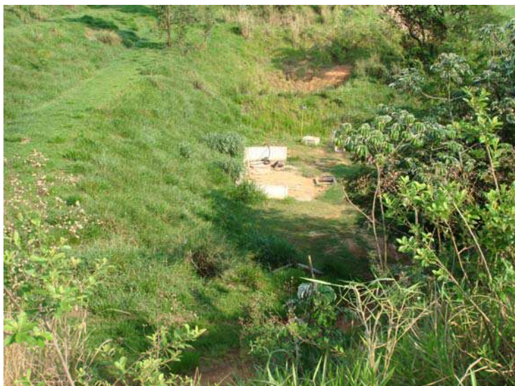
Figura 29 – Sistema de captação do chorume do Aterro Sanitário de Mogi Mirim – 25.11.2007.
