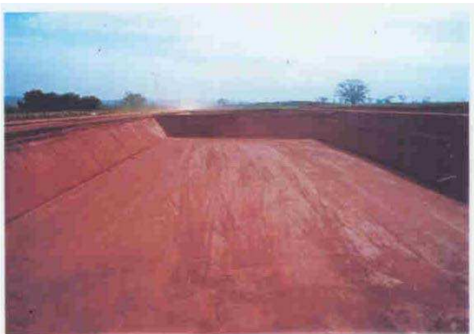
Figura 05: Abertura da Trincheira Fonte: Fernando Wolmer, 2007, CETESB, arquivo pessoal
