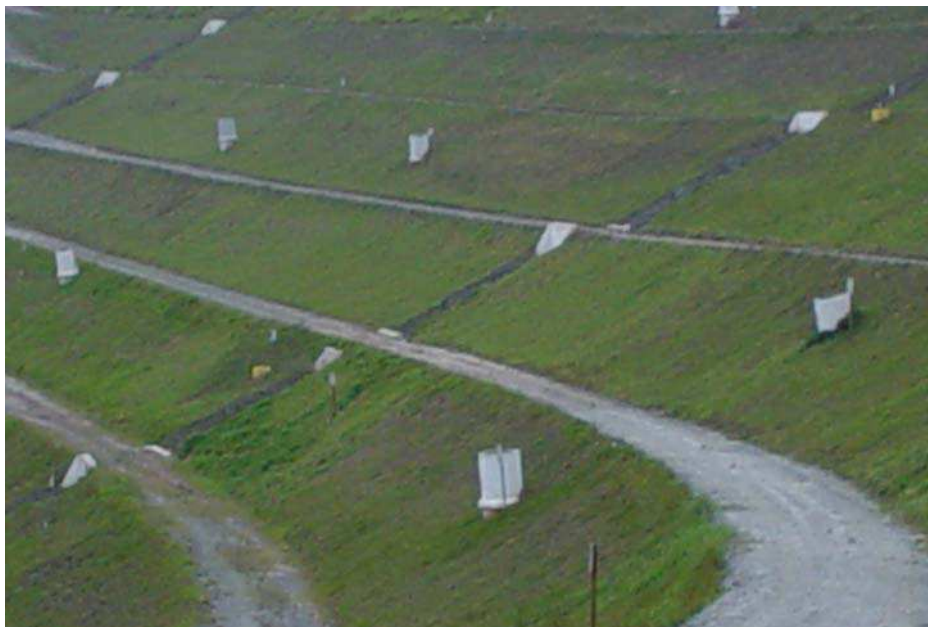
Figura 16: Exemplo de aterro sanitário convencional em camadas localizado em encosta. Na fase final podemos observar a estabilização da encosta promovida pela compactação dos taludes e a impermeabilização com cobertura vegetal e sistema de drenagem das águas pluviais. Observa-se ainda o sistema de drenagem dos gases.
