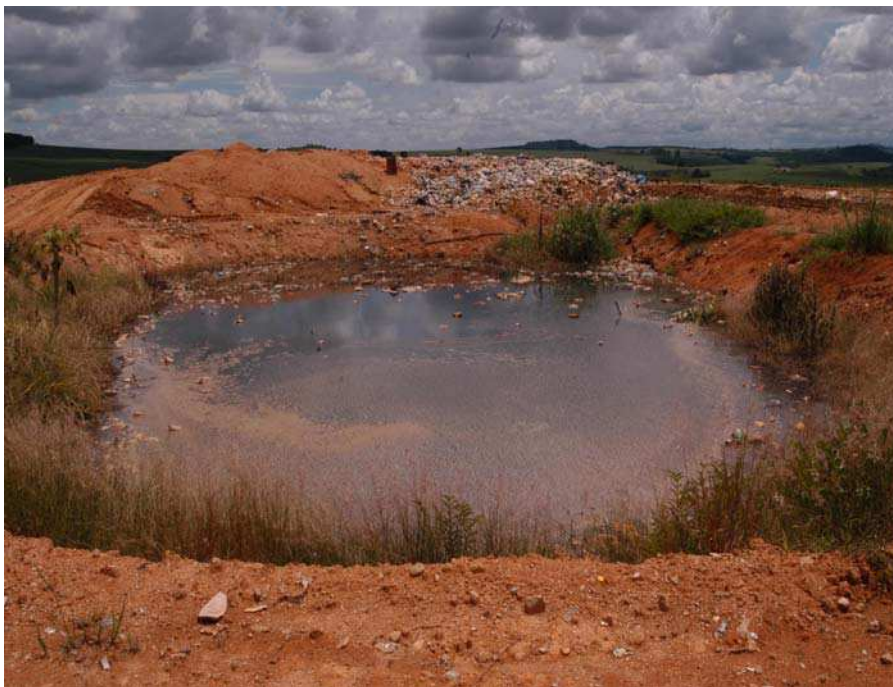
Figura 25 – Aterro Sanitário de Mogi Mirim – 14.03.2007. Lagoa recirculação de chorume, sem impermeabilização e instalado no ponto alto do aterro. Fonte: Luís Augusto Bresser Soares, 2007, FMPFM, arquivo pessoal
