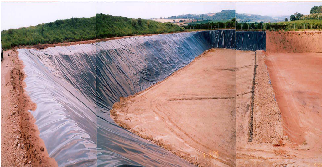
Figura 07: Instalação da geomembrana de PEAD sobre camada de solo argiloso compactado na Trincheira. Num segundo momento a instalação do sistema de drenagem das águas percoladas (Chorume) e de gás metano (biogás) em meio ao solo argiloso compactado
