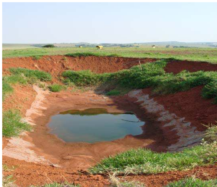
Figura 28 – Aterro Sanitário de Mogi Mirim – 25.11.2007. Lagoa recirculação de chorume, continua sem impermeabilização e instalado no ponto alto do aterro, apenas uma pequena manta de bidin.
