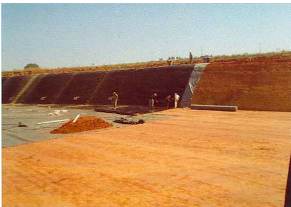
Figura 06: Instalação da geomembrana de PEAD ( Polietileno de Alta Densidade, de 2,0 (dois) milímetros de espessura) sobre camada de solo argiloso compactado na Trincheira.
