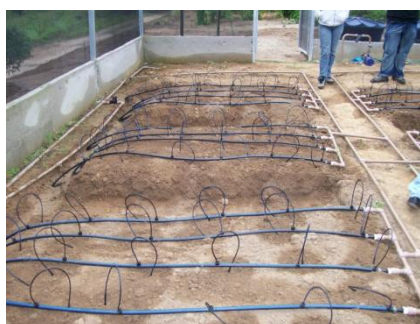
(a) montagem das linhas de irrigação
