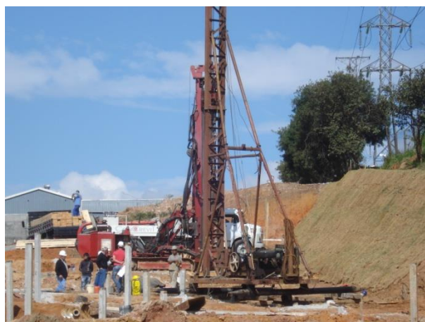
Figura 4 - Vista do bate estacas analisado a partir do ponto de medição 4
