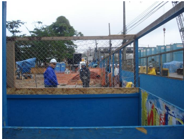
Figura 6 - Vista do rompedor de concreto a partir do ponto de medição 6
