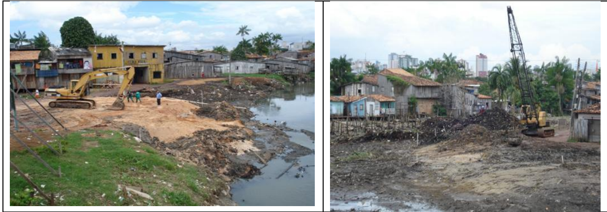
Figura 11. Imagens de início das obras no Igarapé Tucunduba após a remoção das casas.
