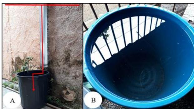
**Figura 4.** Sistema para captação de água de precipitação. A- Captação, B- Armazenamento e decantação. Fonte: SALVADOR, L.F.S. 2019.
