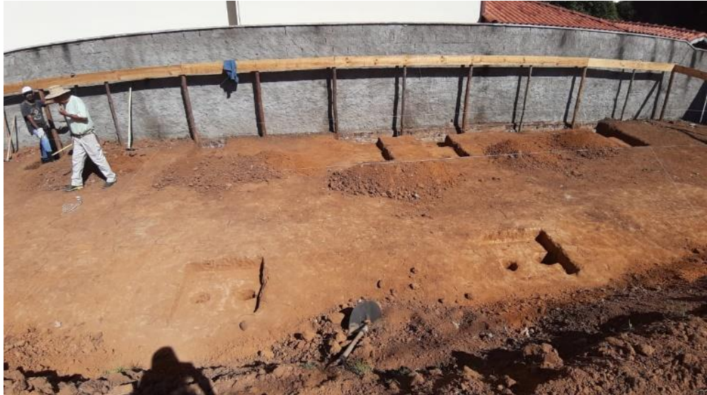
Figura 5 – Abertura das Sapatas de Fundação (2020)
