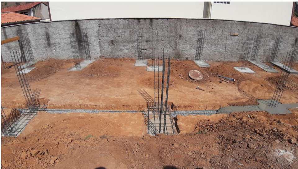
Figura 6 – Concretagem das Sapatas (2020)
