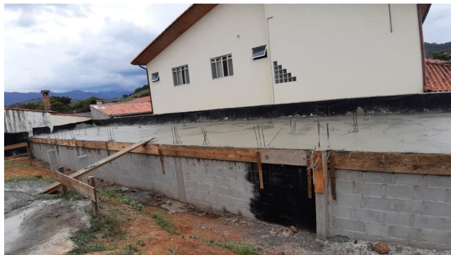
Figura 8 – Concretagem da laje
