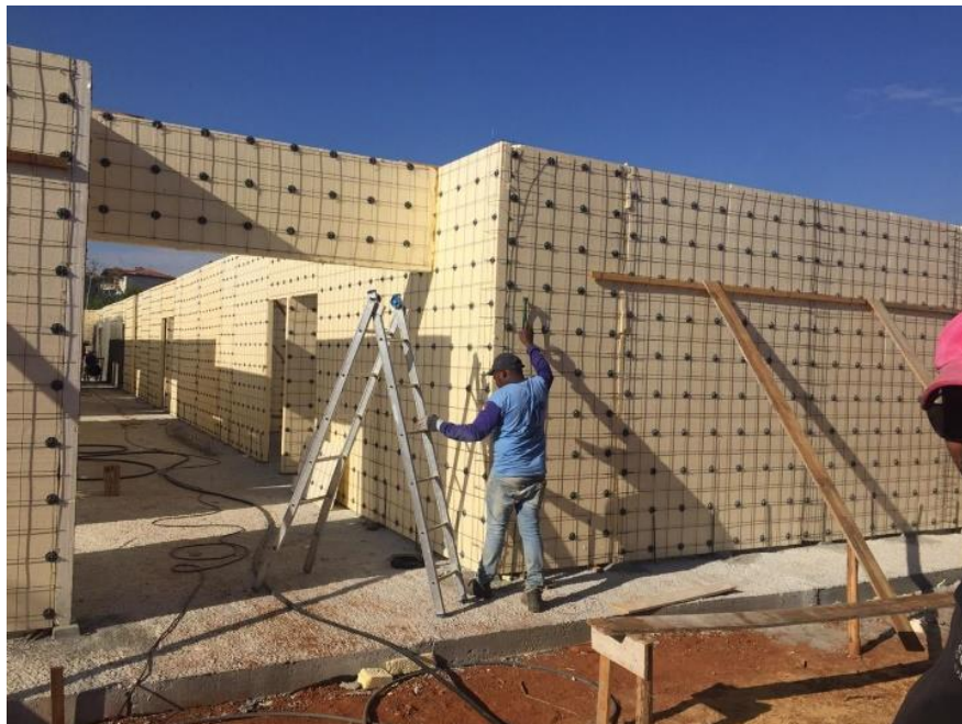
Figura 9 – Escoramento dos painéis
