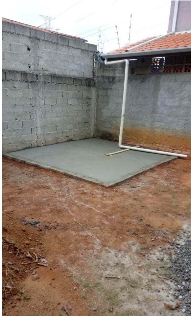
Figura 17 – Base do reservatório
