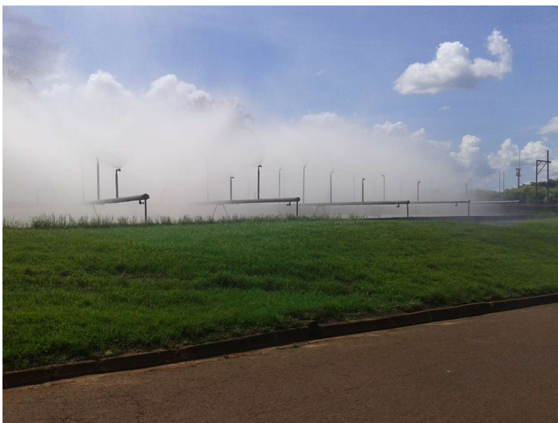
Figura 8 – Sistema de refrigeração por aspersão, de baixa eficiência hídrica da piscina de água bruta.
