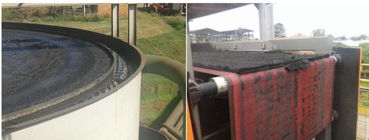
Figura 40 - Sistema de decantação, flotação e secagem de cinzas e fuligem
