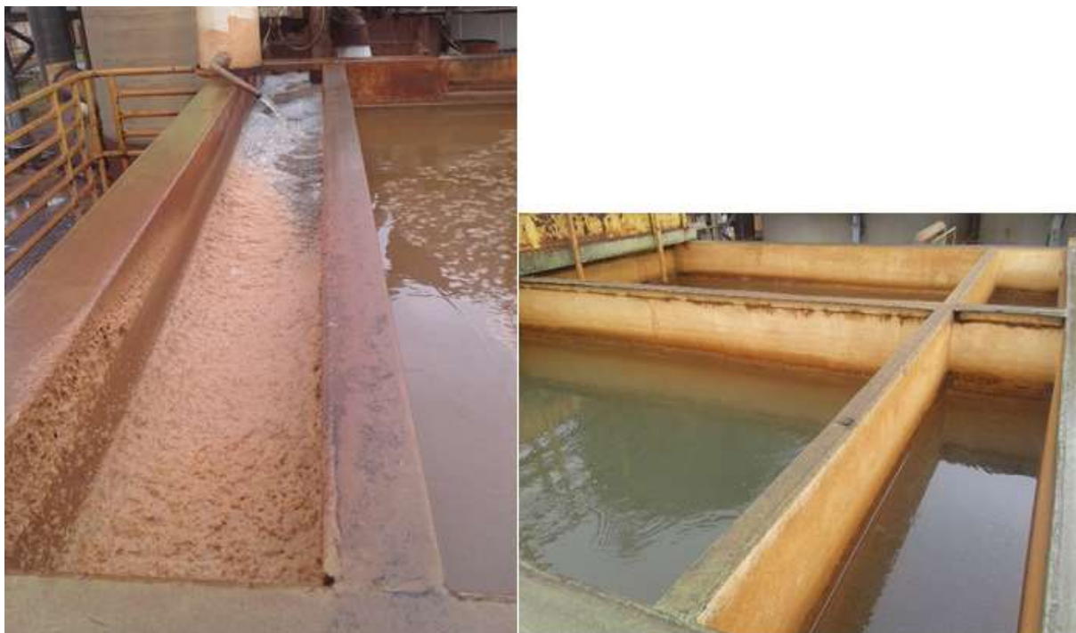
Figura 5 – Aspecto visual da água na entrada (direita) e saída (esquerda) do processo de clarificação
