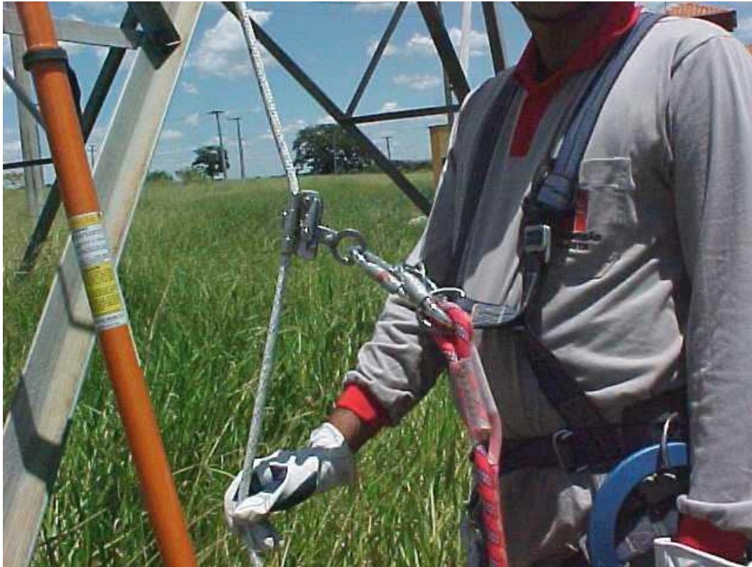
Figura 21 Conexão trava-queadas a corda Fonte: ISA CTEEP (2009)
