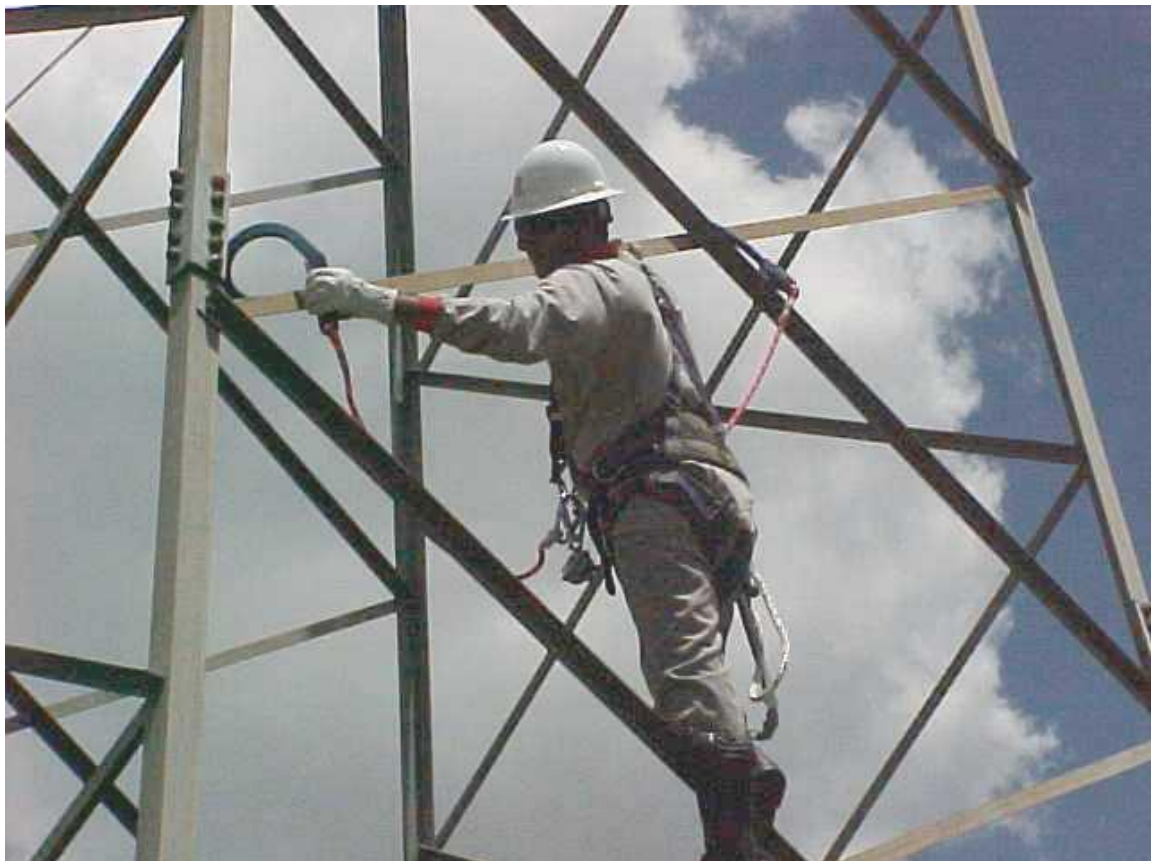
Figura 27 Movimentação com ganchos Fonte: ISA CTEEP (2009)
