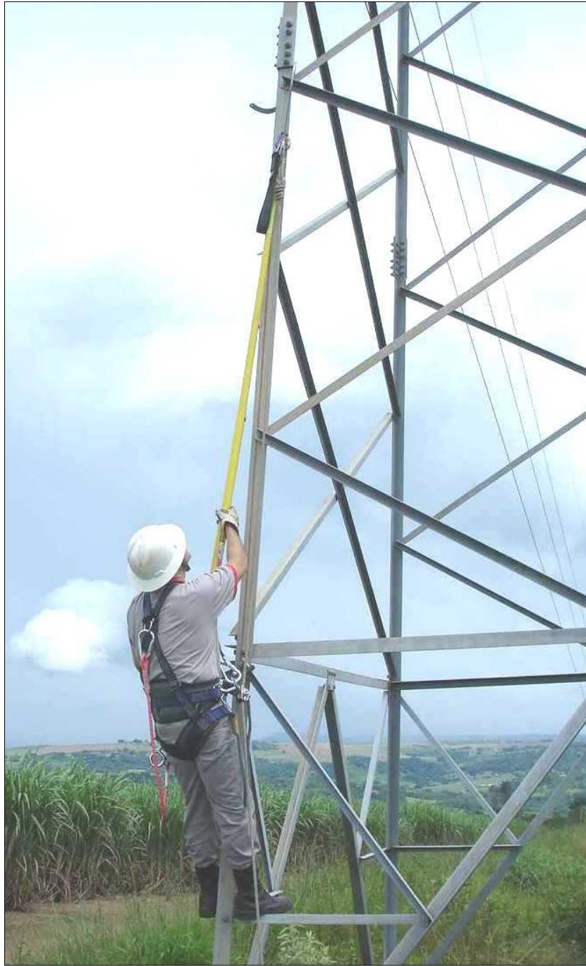
Figura 20 Posicionamento conjunto bastão e gancho de ancoragem Fonte: ISA CTEEP, 2009.
