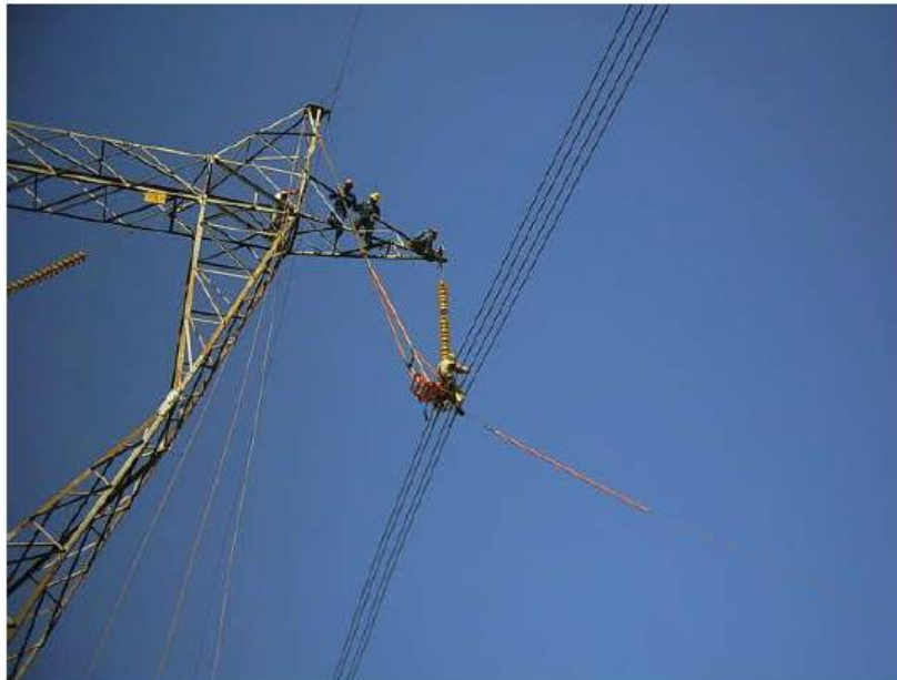
Figura 6 Atividade em estrutura de linha de transmissão. Fonte: SOBES (2010)
