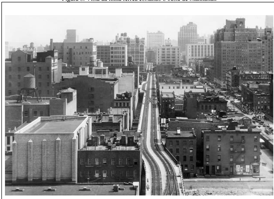
Figura 8. Vista da linha férrea cortando o oeste de Manhattan
