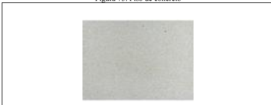
Figura 73. Piso de concreto
