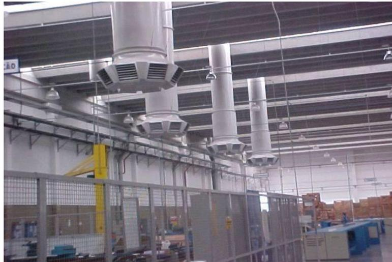
Figura 21: Sistema de Ventilação Geral.
