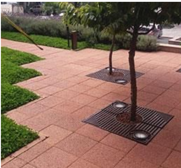
Figura 92 — Piso drenante cimentício
