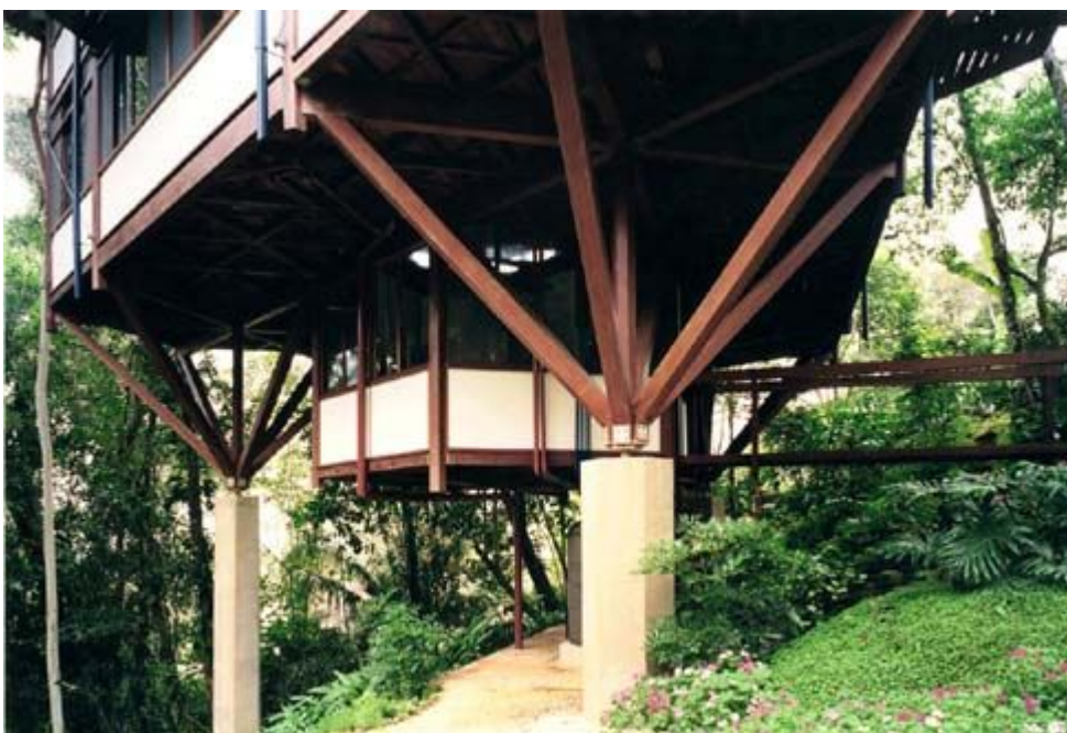
Figura 41 — Pilares de concreto sustentando a residência
