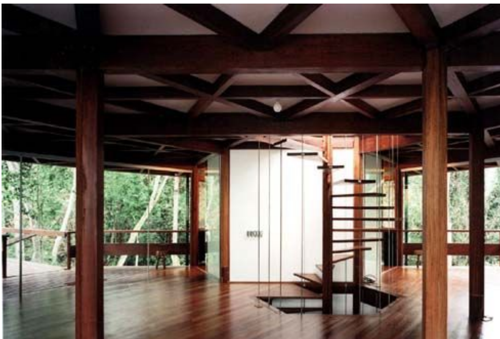
Figura 43 — Escada de madeira e cabos de aço
