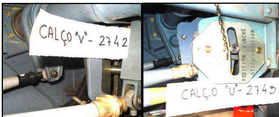
FIGURA 29 - Unidade misturadora esquerda com calços instalados
