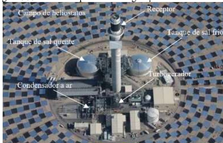
Figura 568: Blocos de potência e de geração da usina Gemasolar
