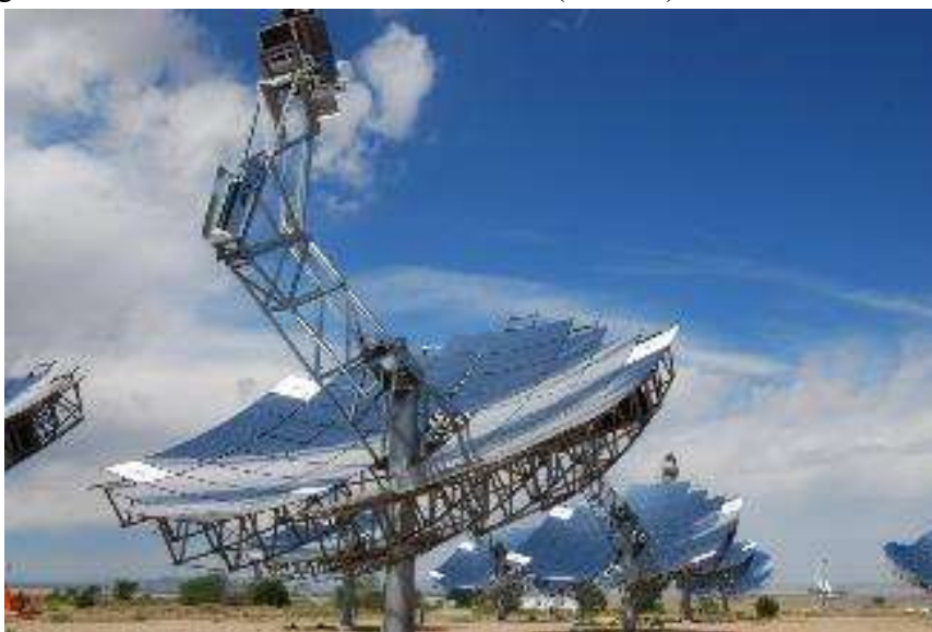
Figura 112: Usina de concentrador WGA (Mod. 1) – Laboratório Sandia
