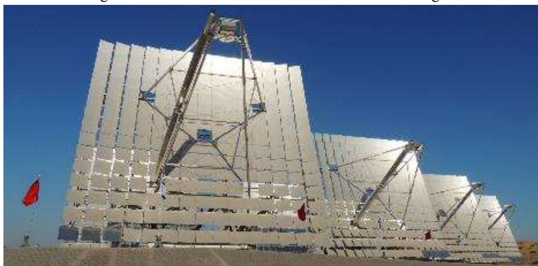
Figura 115: Usina de concentrador HelioBooster –Mongólia
