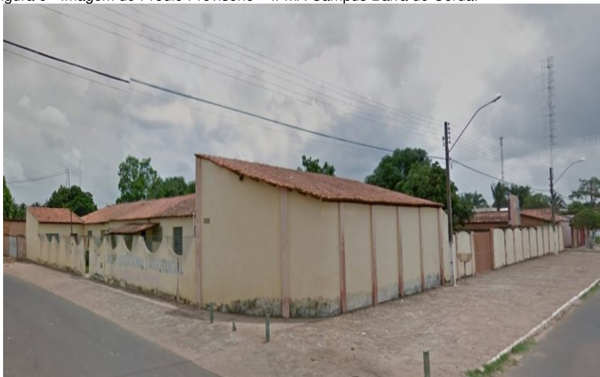
Figura 6 - Imagem do Prédio Provisório – IFMA Campus Barra do Corda.
