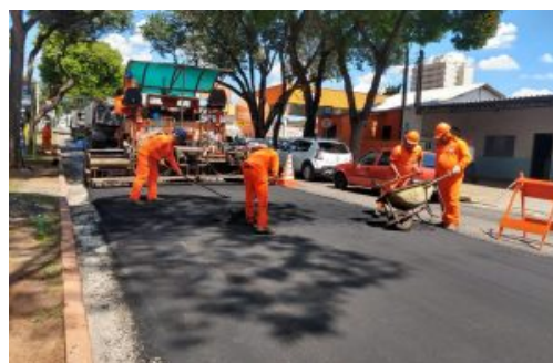
Figura 15 - Asfaltamento na Avenida Andrômeda
