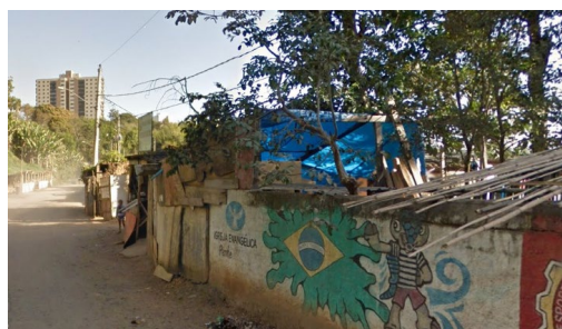
Figura 20 – Condomínio de casas na Rua José G. de Almeida
