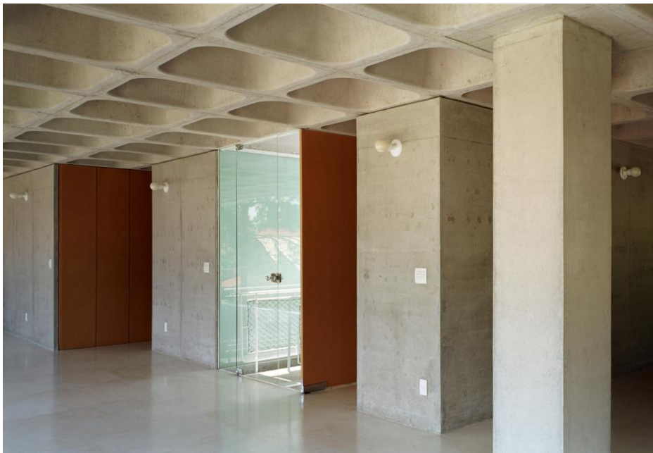
Figura 15 - Painéis de argamassa armada e laje nervurada – Casa da Aldeia da Serra Fonte: Via Archdaily
