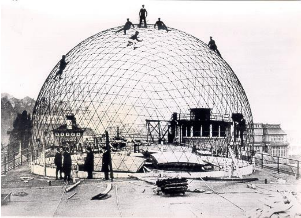
Figura 1 - A Cúpula de Jena, Alemanha 1992 Fonte: Construções de Argamassa Armada, pág. 21.
