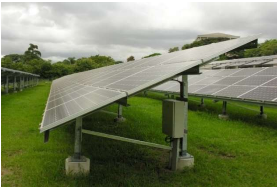
Figura 11: Sistema de solo onde gera maior parte da energia do campus, Fonte: Autora, 2019
