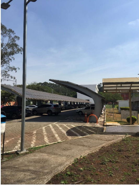
Figura 9: Estacionamento utilizando painéis solar como cobertura, Fonte: Autora, 2019
