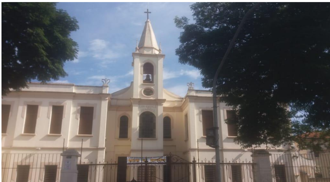
Figura 52 - Fachada Lar Escola Santa Verônica
