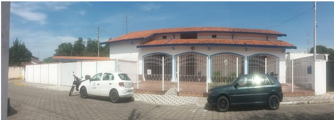
Figura 39 - Panorâmica da Fachada
