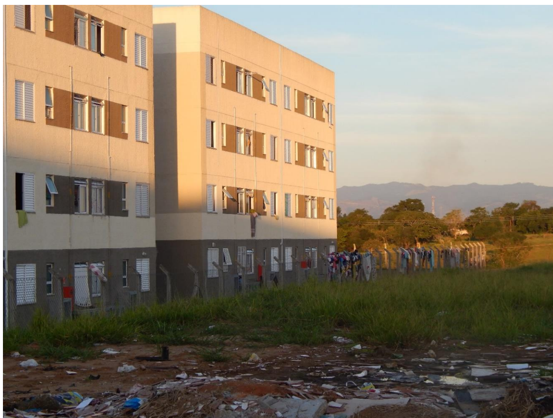
Figura 46 – Limites do Conjunto Residencial.
