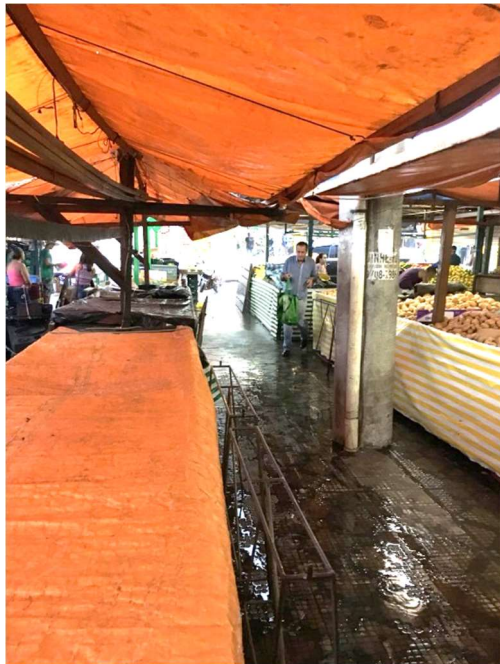
Figura 78 – Desníveis no piso do mercado
