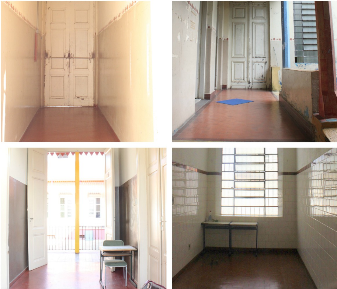
Figura 19 - Piso Cerâmico Fonte: Produzido pela autora (2018).
