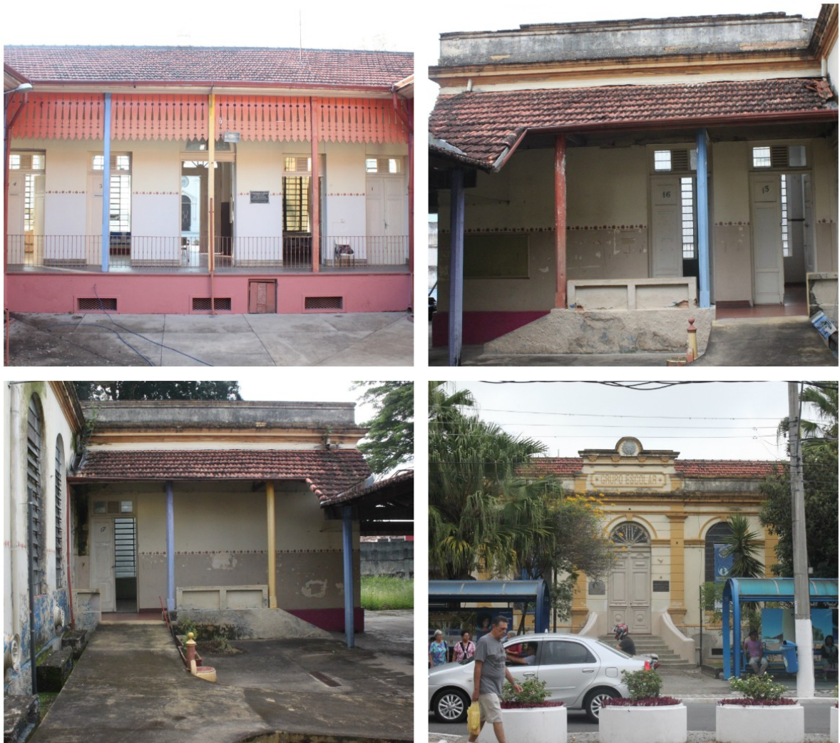
Figura 16 - Vista do telhado Fonte: Produzido pela autora (2018).
