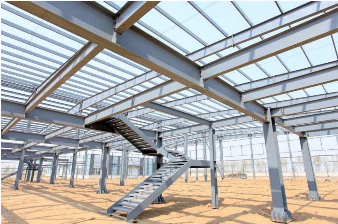
Figura 30 Estrutura em aço.
