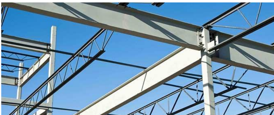
Figura 29 Estrutura em aço
