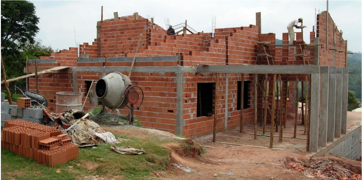
Figura 20: exemplo de construção com alvenaria convencional
