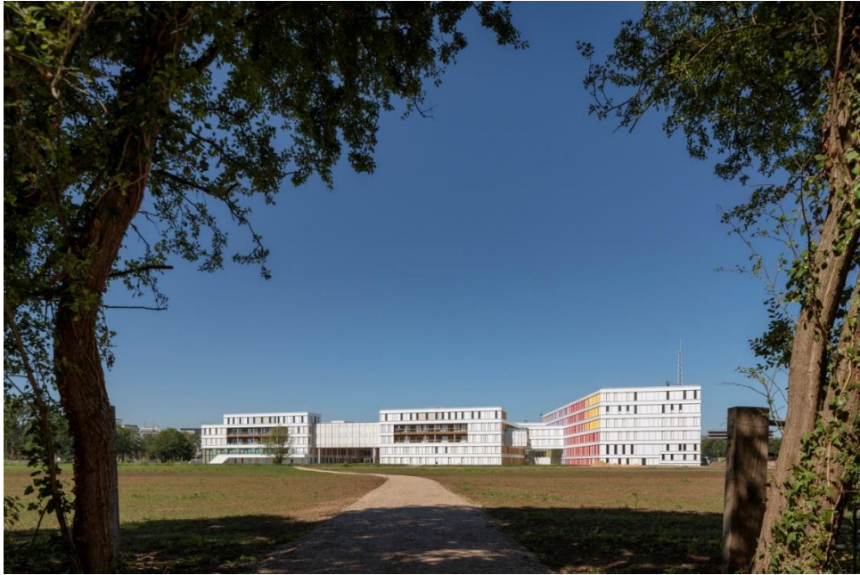
Figura 06: Vista lateral do edifício
