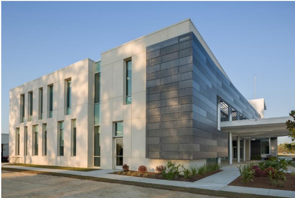
Figura 09: vista lateral do edifício
