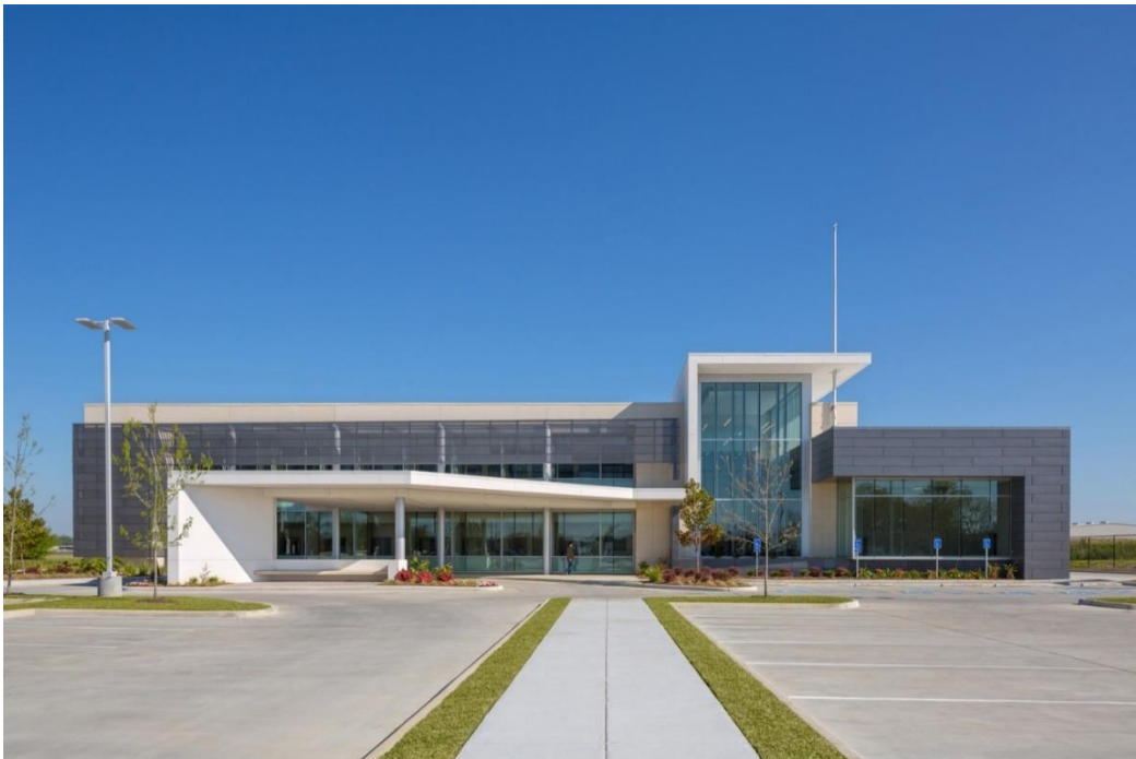
Figura 08: fachada da sede de serviços
