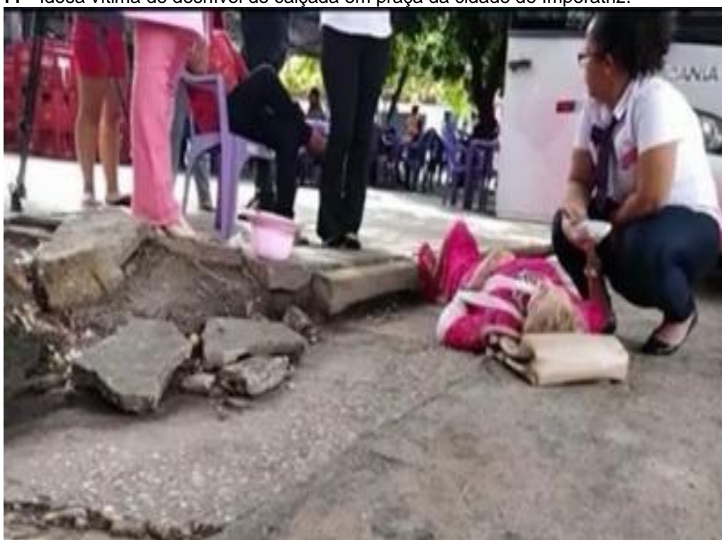
Figura 11 - Idosa vítima de desnível de calçada em praça da cidade de Imperatriz.
