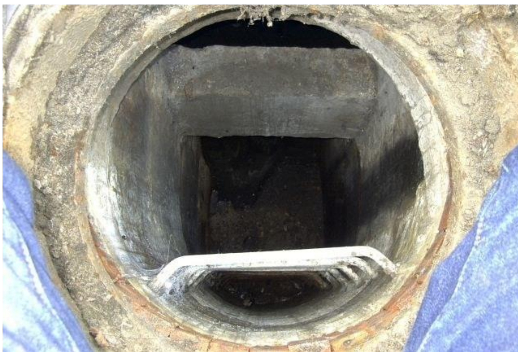
Figura 6: Acesso ao canal original do rio Woluwe.
