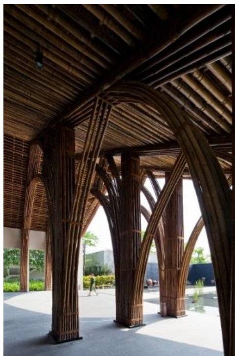
Figura 14. Detalhamento dos bambus Luong (colunas retas) e Tam Vong (arcos), e suas respectivas características e funções.
