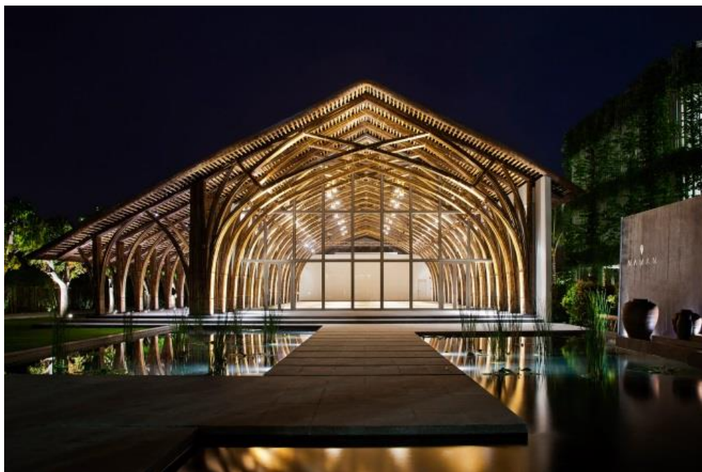
Figura 19. Vista frontal da Sala de Conferências Naman Retreat.
