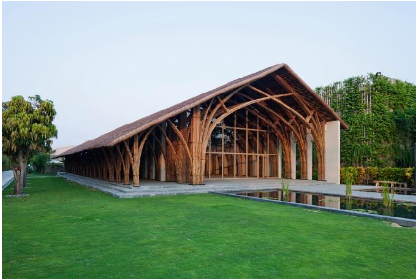
Figura 13. Fachada Oeste do Salão, com hall de entrada à frente e ao lado.
