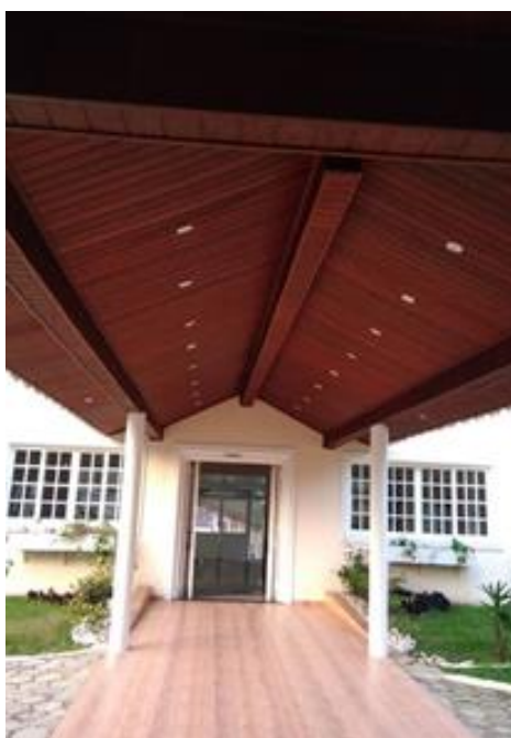
Figura 41. Passagem para o Hall e o Salão Princess .
