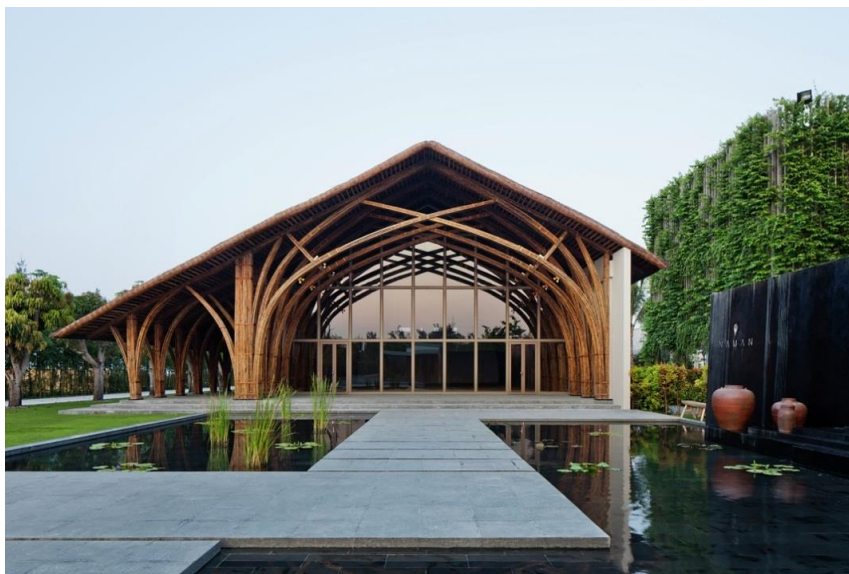
Figura 1. Fachada Salão de Conferências Naman Retreat.
