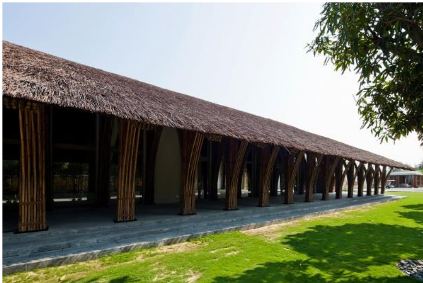
Figura 9. Vista lateral do Salão, mostrando o corredor externo.
