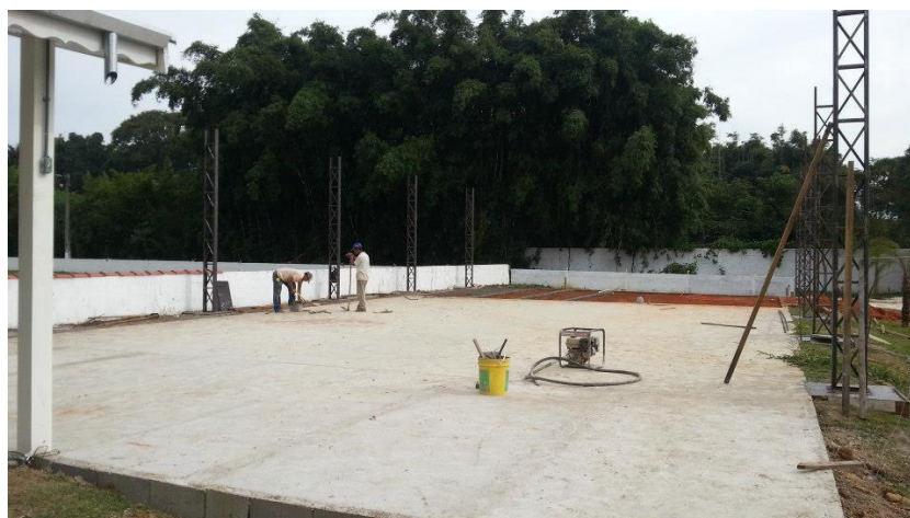
Figura 24. Parte da reforma em 2013 - Construção do novo Salão.
