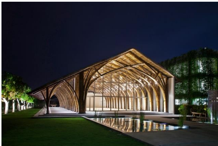
Figura 7. Vista do Salão de Conferências Naman Retreat, exibindo seus 2 ambientes paralelos.
