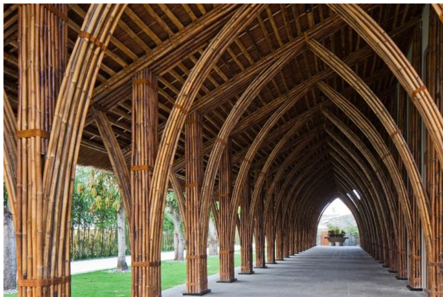
Fonte: Hiroyuki Oki apud . Archdaily, 2018.
