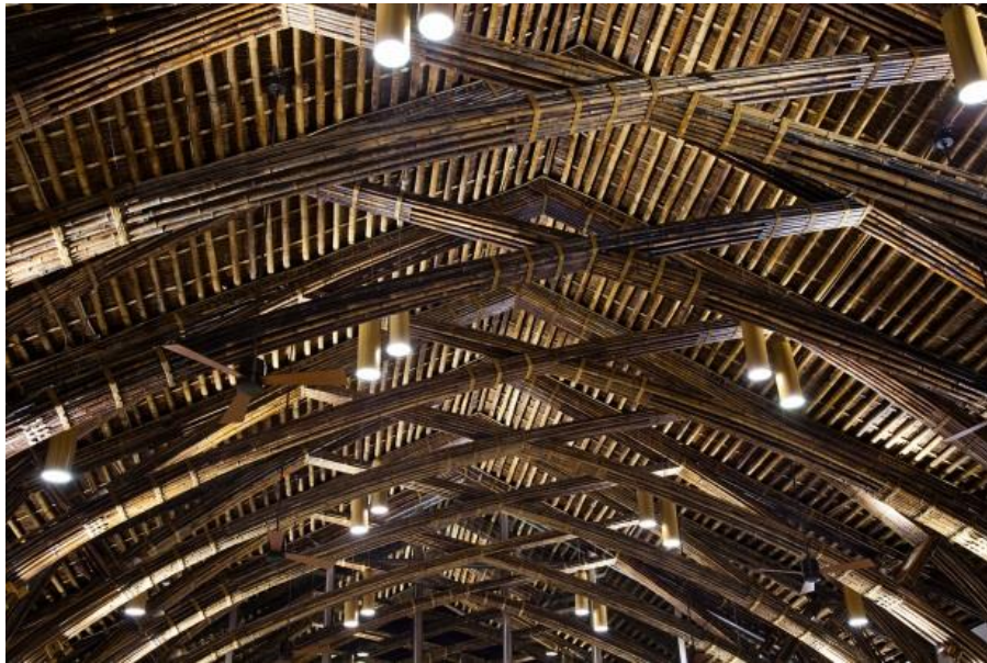
Fonte: Hiroyuki Oki apud . Archdaily, 2018.
