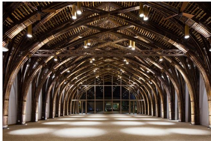
Figura 11. Detalhamento da estrutura interna abobadada do Salão.
