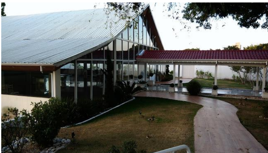
Figura 33. Destaque das telhas de zinco, que ajudam no conforto acústico do Salão, e das grandes janelas de vidro.
