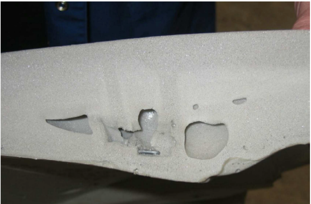
Figura 34 - Falha de furos / espaços vazios
