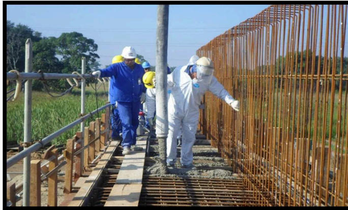
Figura 27 Fotos da Concretagem das Vigas
