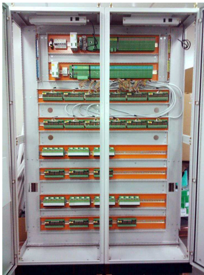
Figura 1.12 – Layout típico de um painel de controle
