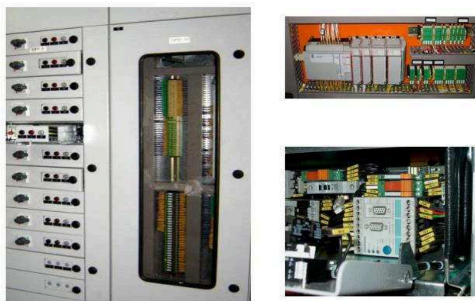
Figura 1.11 – Layout típico de um CCM Inteligente
