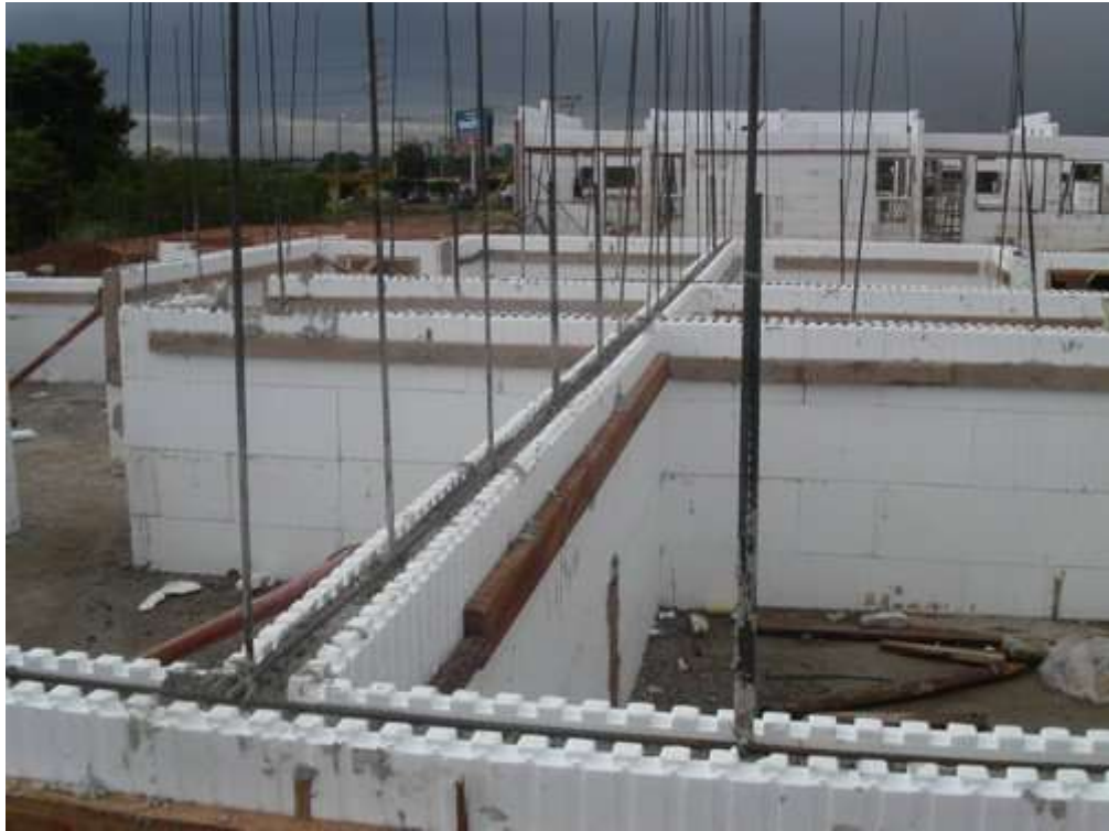
Figura 2 – Encaixe das formas de ICF
