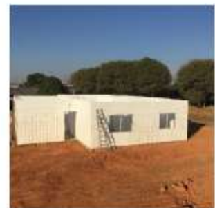
Imagem 09: Obra sem pilares - Caravágio-MT.
