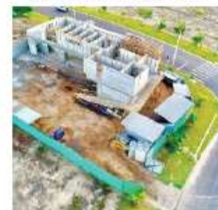
Imagem 12: Obra com 7 pilares, pavimento superior.
