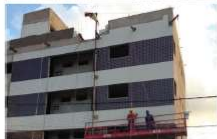
Imagem 06: prédio executado com sistema ICF
