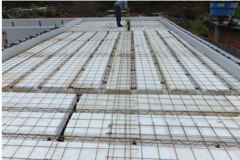
Figura 10 – Laje em uma obra em ICF
