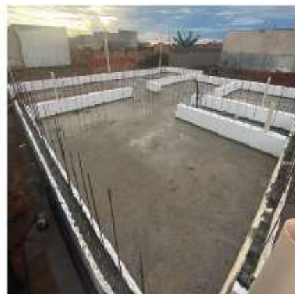
Imagem 14: Radier com a primeira fiada instalada.
