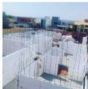
Imagem 07: Obra sem pilares - Goiânia-Go.
