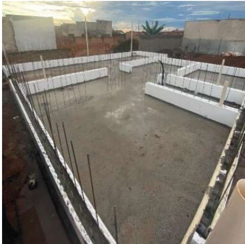
Figura 5 – Limpeza do canteiro de obras
