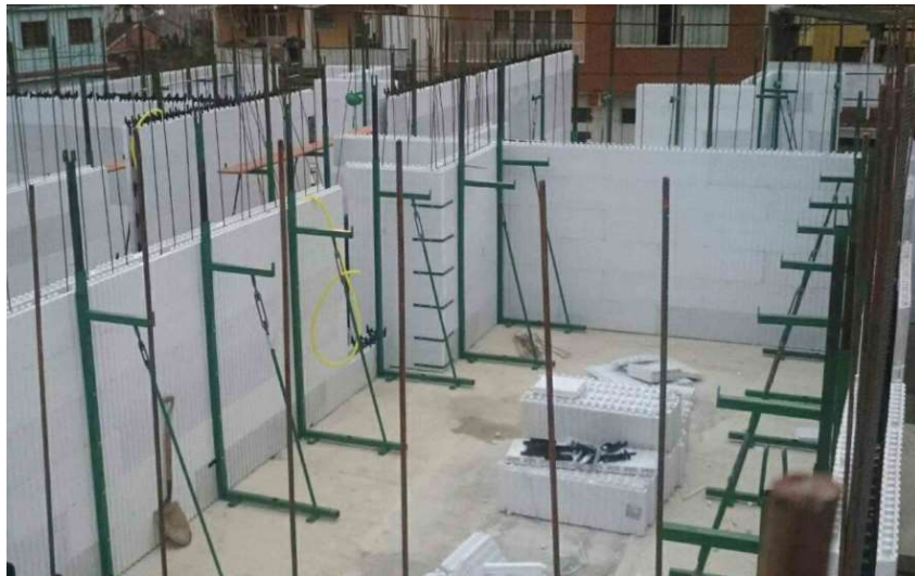
Figura 9 – Paredes em uma obra em ICF
