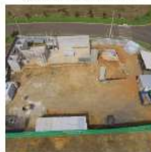
Imagem 10: Obra com 7 pilares, pavimento térreo.
