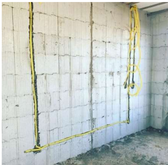
Figura 11 – Instalação de conduítes em uma obra em ICF
