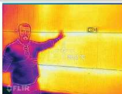
Imagem 04: teste de temperatura em parede de placa de concreto
