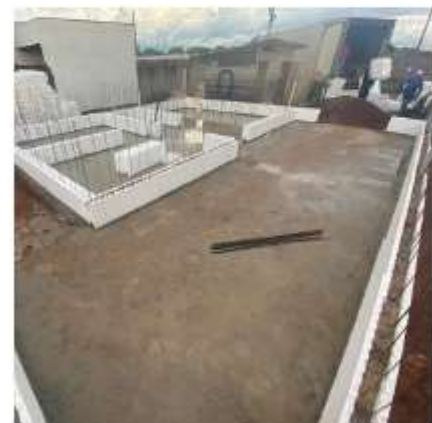
Imagem 15: Praticidade na mobilidade do material e limpeza no canteiro de obra.
