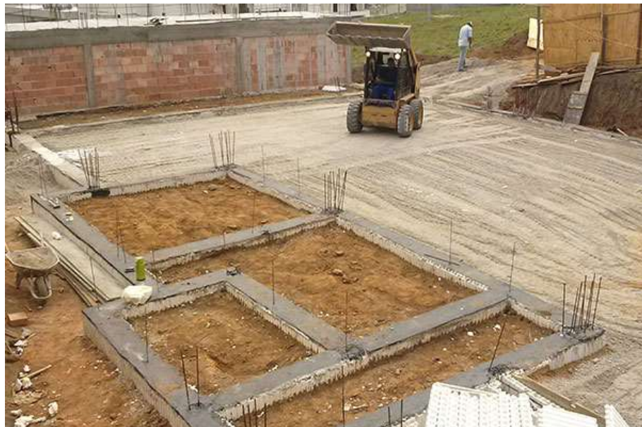
Figura 8 – Fundação em uma obra em ICF
