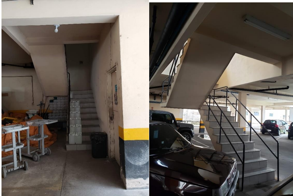
Figura 15 Escada para saída de emergência
