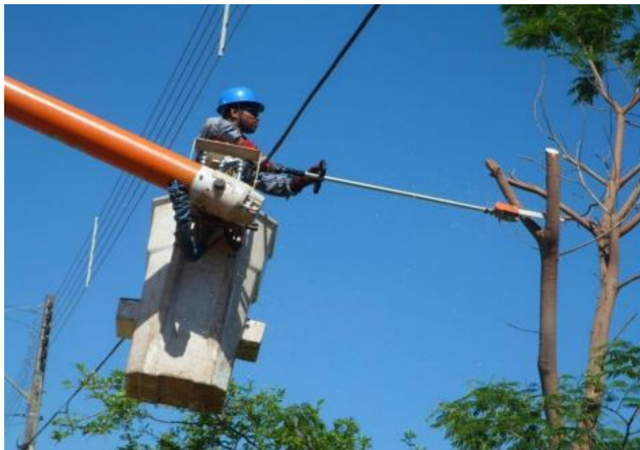
Figura 17 Aplicação do uso de EPI: Auxílio de um cesto elevatório
