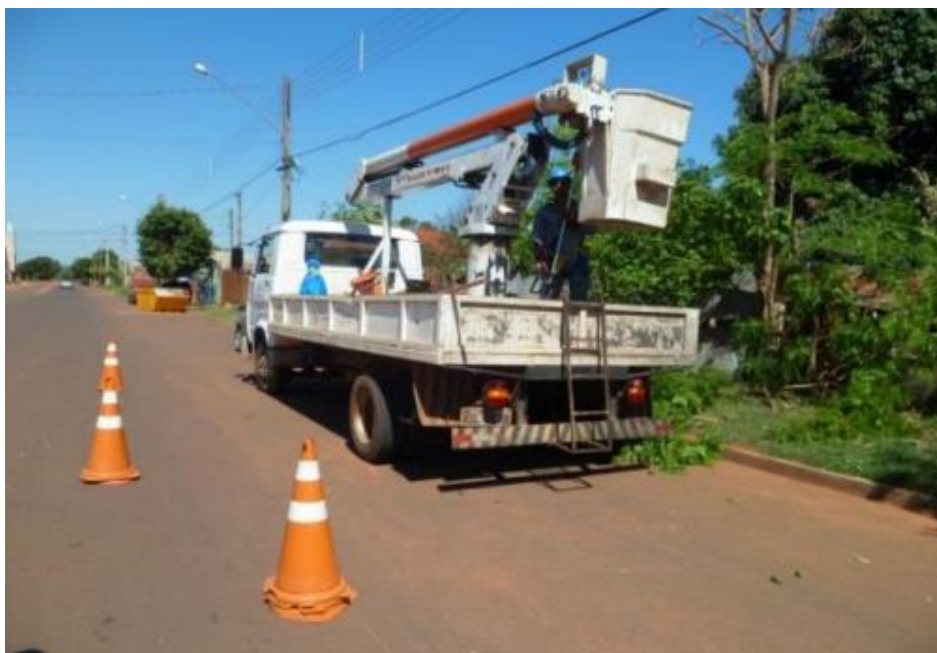
Figura 16 - Aplicação do uso de EPI: caminhão com cesto elevatório e sinalização
