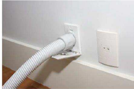
Figura 19 - Tomada do sistema de aspiração central
