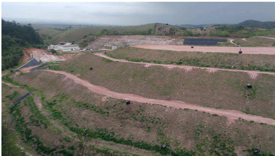
Figura 19: Vista das células do aterro sanitário de Tremembé-SP.
