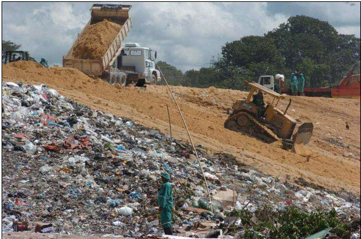
Figura 4: Vista geral de um Aterro controlado.
