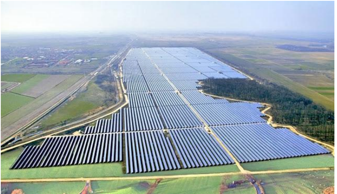
Figura 33 - Maior usina fotovoltaica do Brasil
