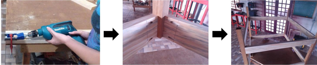
Figura 33: Montagem da estrutura da mesa de fixação da máquina
