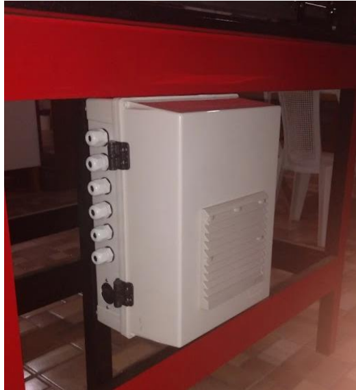
Figura 55: Fixação do painel elétrico na mesa da máquina
