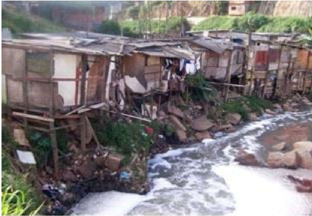
Figura 11 – Córrego do Canivete em 2006, antes da intervenção.
