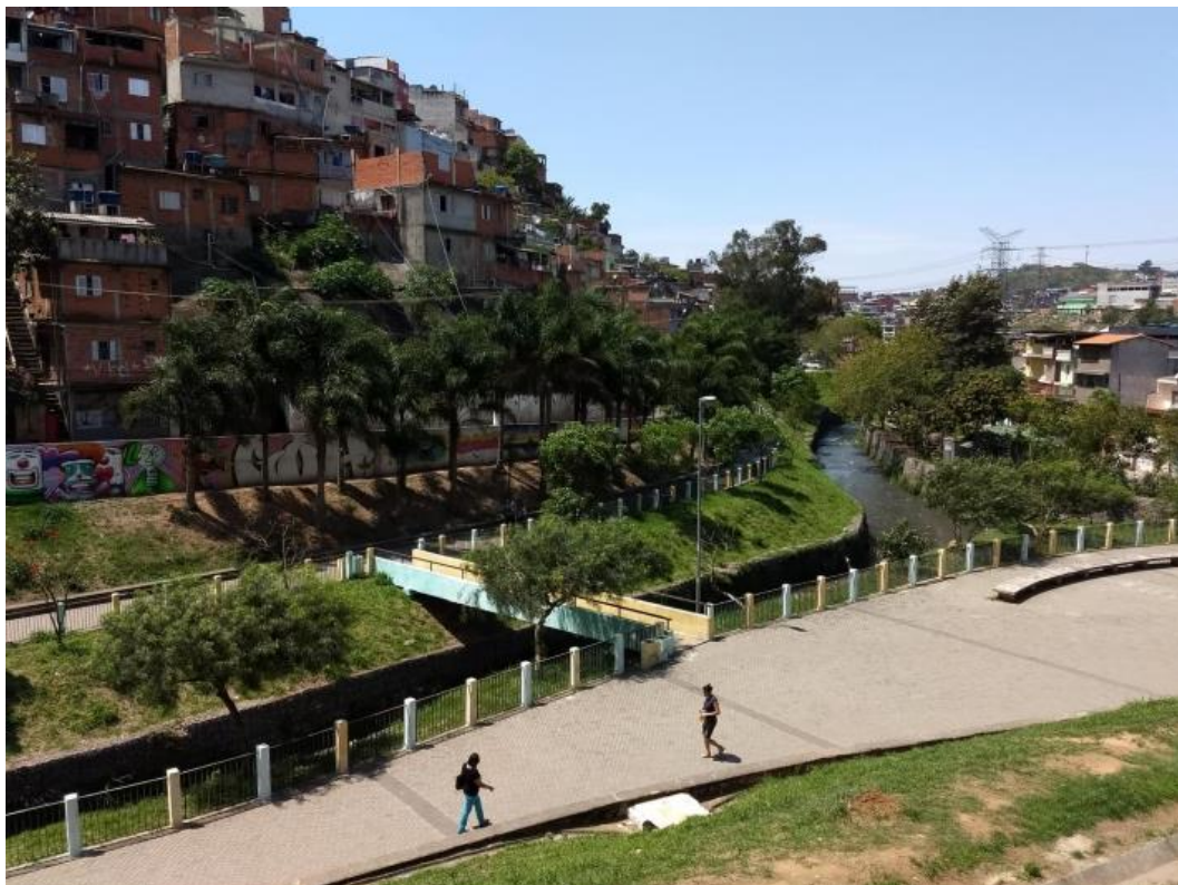
Figura 12 - Córrego do Canivete, depois da intervenção.
