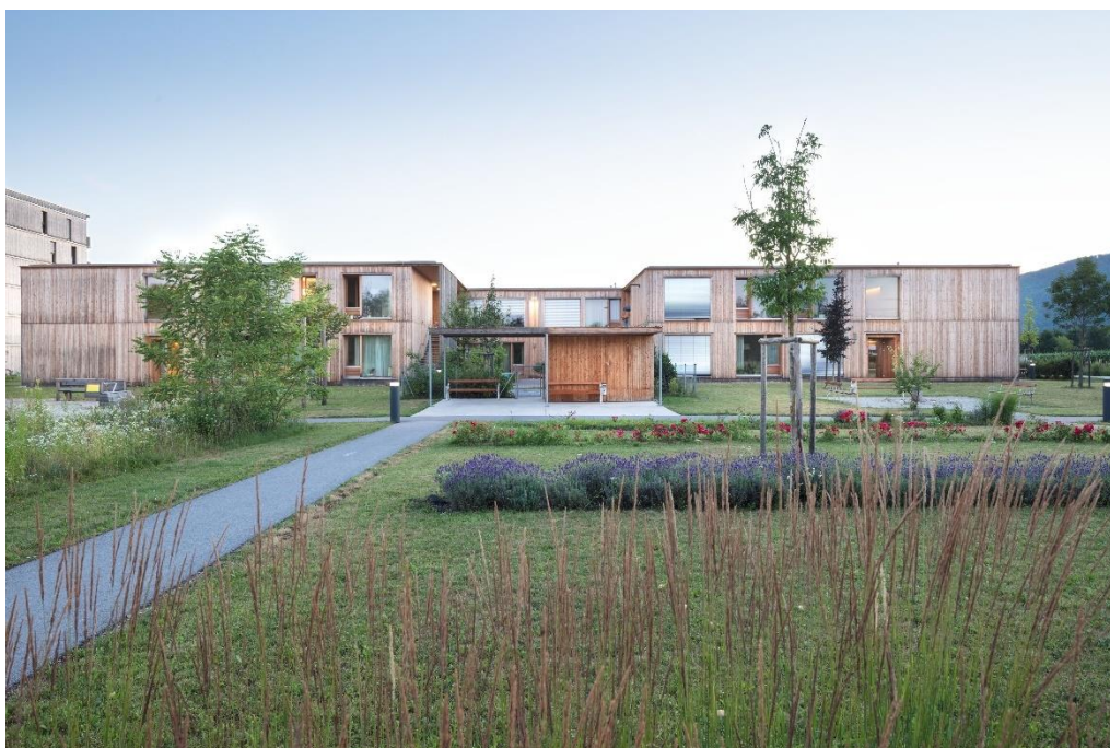
Figura 16 – Fachada leste do edifício.
