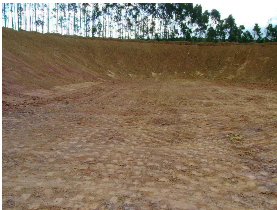
Figura 6 – Solo compactado
