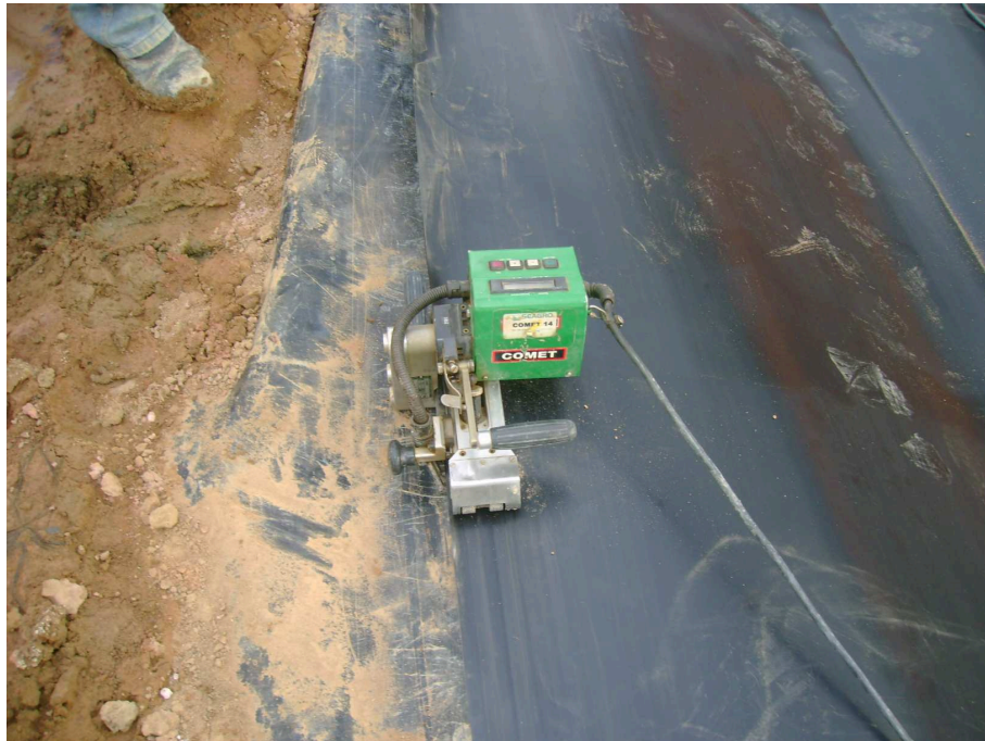
Figura 8 – Soldagem das mantas
