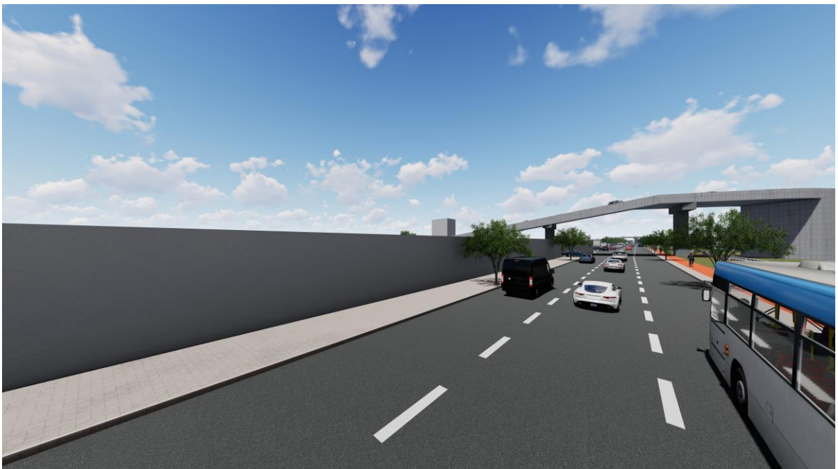
Figura 48 - Rua Dino Bueno, (corredor Leste-Oeste) Três faixa de rolagem, sendo uma exclusiva para transporte público
