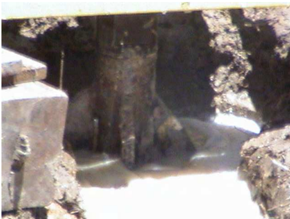
Figura 9 – Broca tipo “rabo de peixe” utilizada no início das perfurações.
