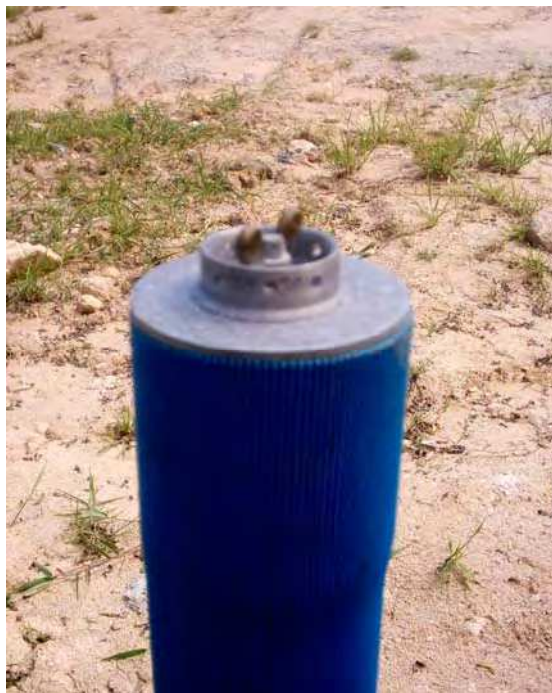
Figura 11 – Aspecto do poço finalizado sem caixa sanitária.
