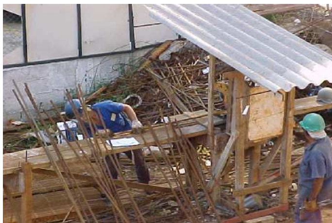
Figura 13: Estado Inicial (EMPRESA B): Desorganização e Desperdício de Materiais
