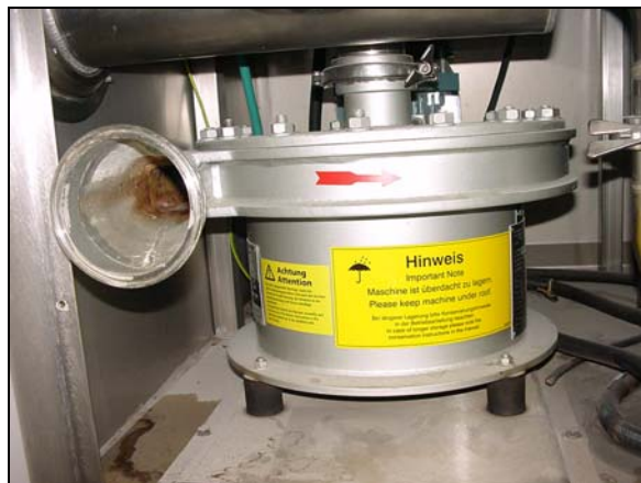
Figura 3.20 - Turbina para sistema de captação de ar.
