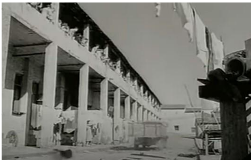
Figura 3 - Conjunto habitacional localizado no Beco do Conforto (00:13:00)
