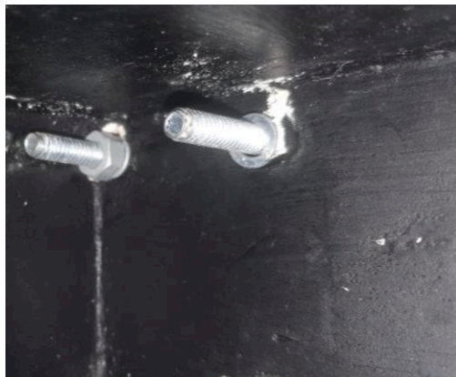
Figura 25 – Fixação do anemômetro com parafusos direto na madeira
