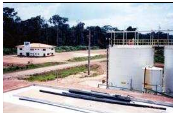
Figura 3: Instalação da RCC/SA
