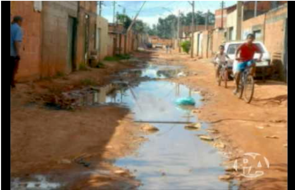
Figura 17. Vista geral do de uma rua sem sistema de saneamento básico instalado em um bairro da cidade de Imperatriz-MA
