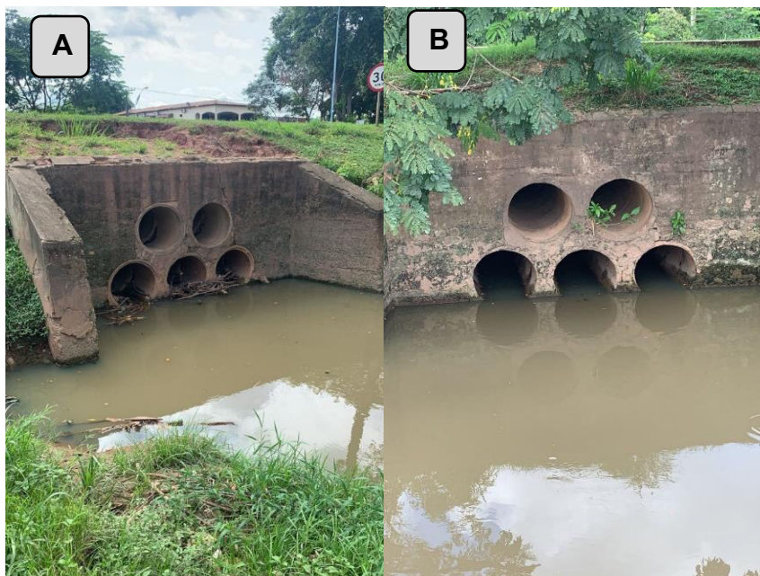
Figura 7, a e b - Bueiro da Rod. BR-010
